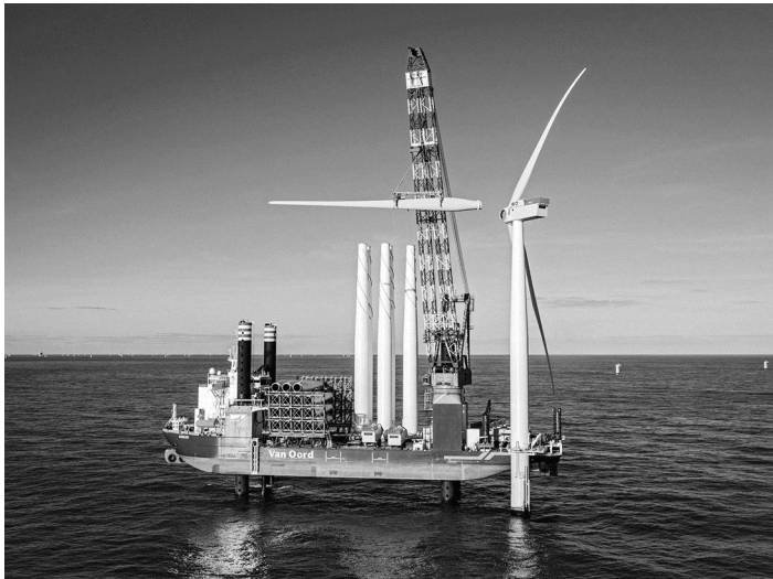
Gemini offshore windpark, in aanbouw
