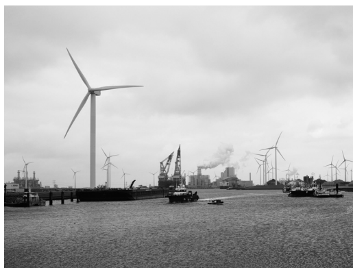
Eemshaven: de energiehaven van Noord-Nederland
